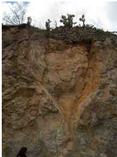
Fig. 45 – Esempio di scivolamento di un cuneo di roccia.
